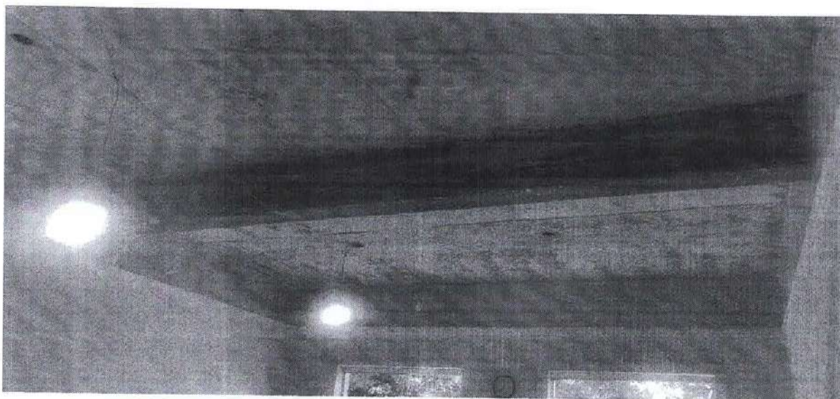
Foto 03: sala 02 – para instalação de gesso rebaixado
